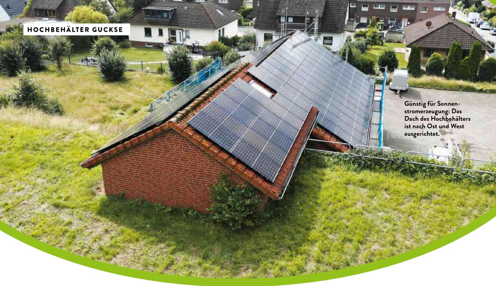
Günstig für Sonnenstromerzeugung: Das Dach des Hochbehälters ist nach Ost und West ausgerichtet.
