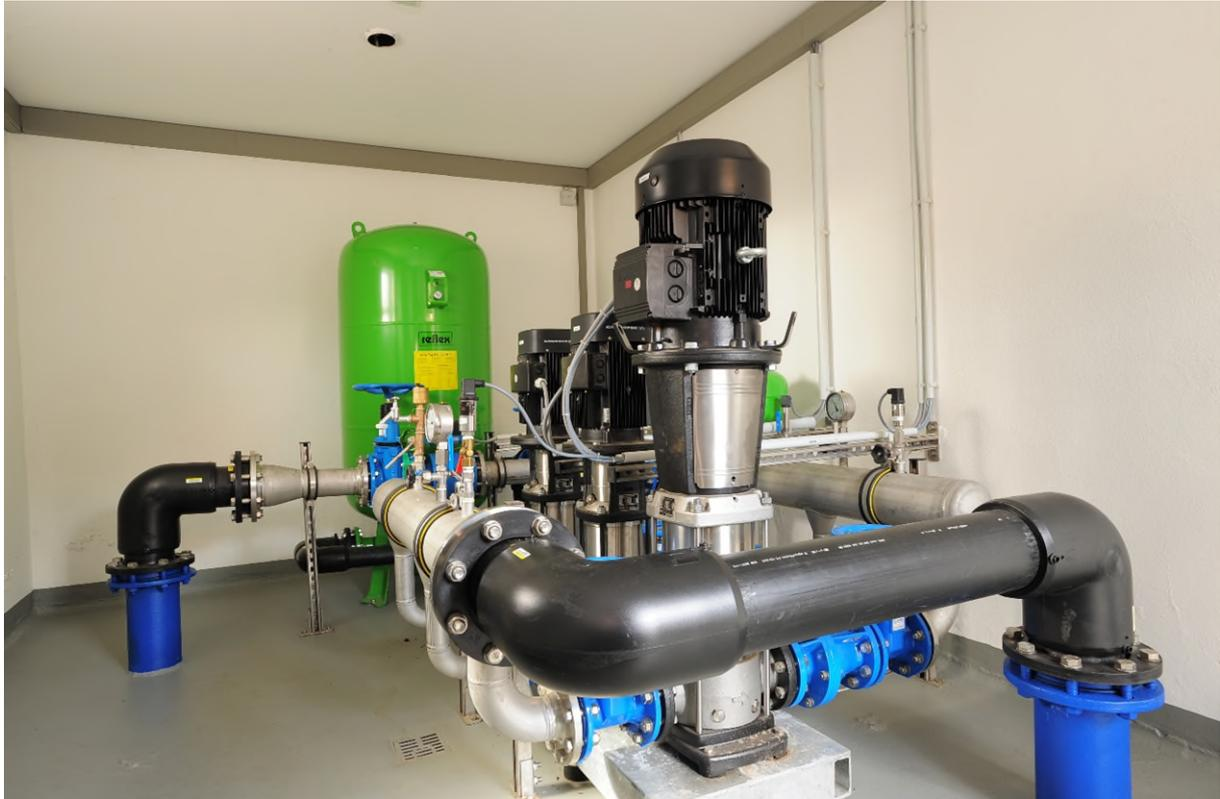
**Bildunterschrift:** Mithilfe der Druckerhöhungsstation gelangt das Wasser in höher gelegene Versorgungsgebiete. (Auf dem Bild ist die Druckerhöhungsstation in Steinbergen zu sehen.)
